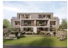
Überbauung «Zwischen den Giessen», Belpbergstrasse (im Bau)
