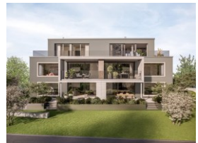
Überbauung «Zwischen den Giessen», Belpbergstrasse (im Bau)
